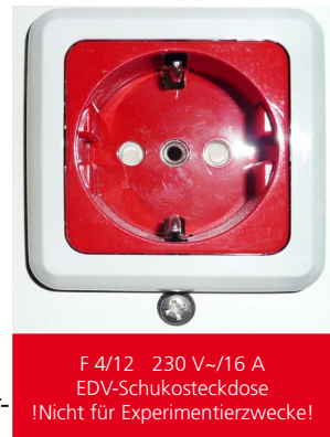
Abb. 16 gekennzeichnete Steckdose
