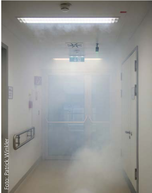
Abb. 4: „Verrauchung“ mit Nebelfluid in einem Gang eines Krankenhauses
