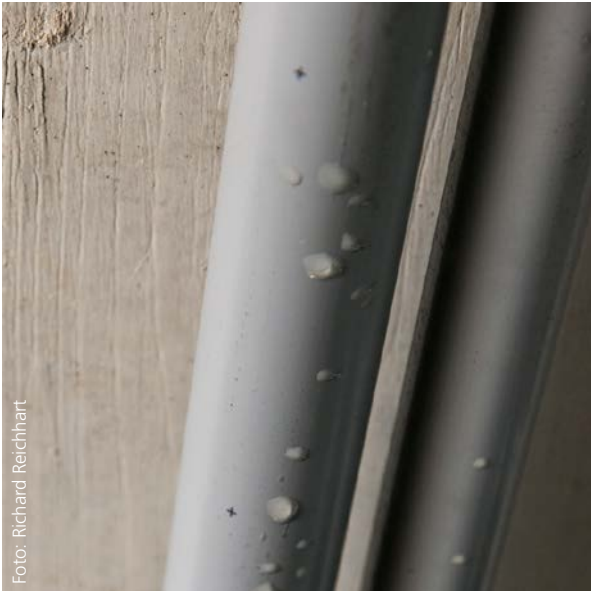
Abb. 3: Ablagerung von Nebelfluidtropfen an Rohrleitungen aus Kunststoff
