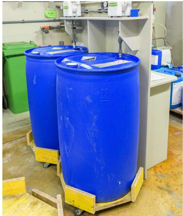
Abb. 6: Eine Fullstation erspart das handische Einsetzen und Herausheben von Fasspumpen in Chemikalienfasser und damit die Gefahr des Verspritzens oder Verschuttens von gesundheitsgefahrlichen Flussigkeiten.
