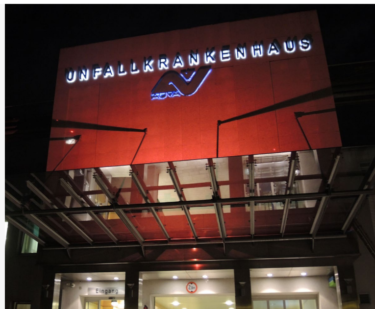
Neben weltweit 130 Gebäuden setzte auch das UKH Salzburg – orange beleuchtet – ein Zeichen.
