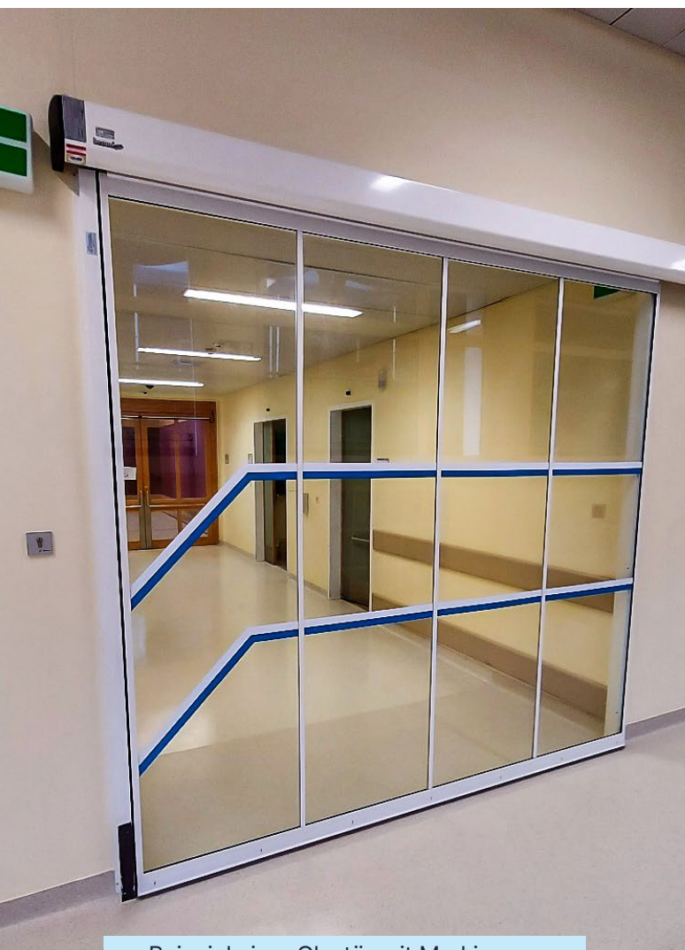
Beispiel einer Glastür mit Markierung
