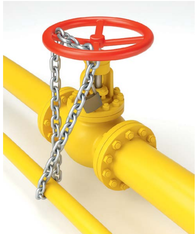
Abb. 5: Absperren von Armaturen
