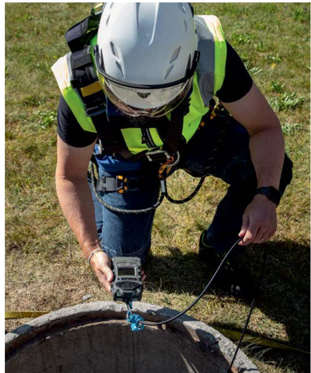
Abb. 6: Freimessen vor dem Einstieg
