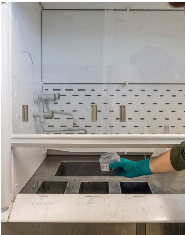
Abb. 23: Eine abgesaugte Entsorgungsstation mit einem Abfluss in einen zentralen Formalin-Sammelbehälter, der sich außerhalb des Gebäudes befindet
