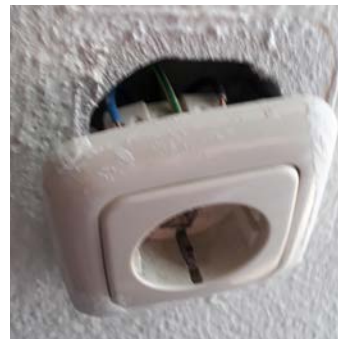
Abb. 9: Beschädigte Steckdose teilweise aus der Wand gerissen
