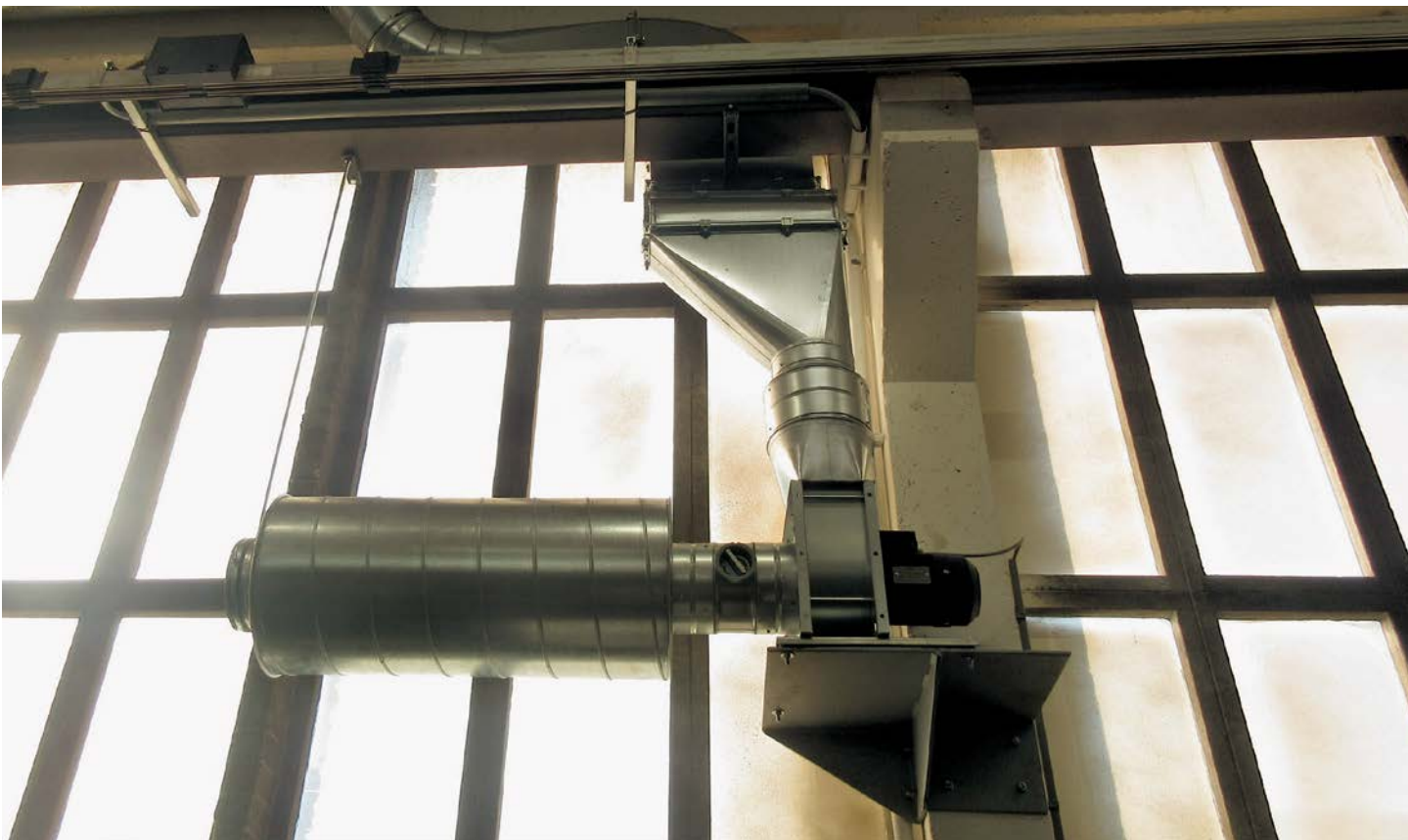
Abb. 5: Schalldämpfer bei einer Absauganlage
