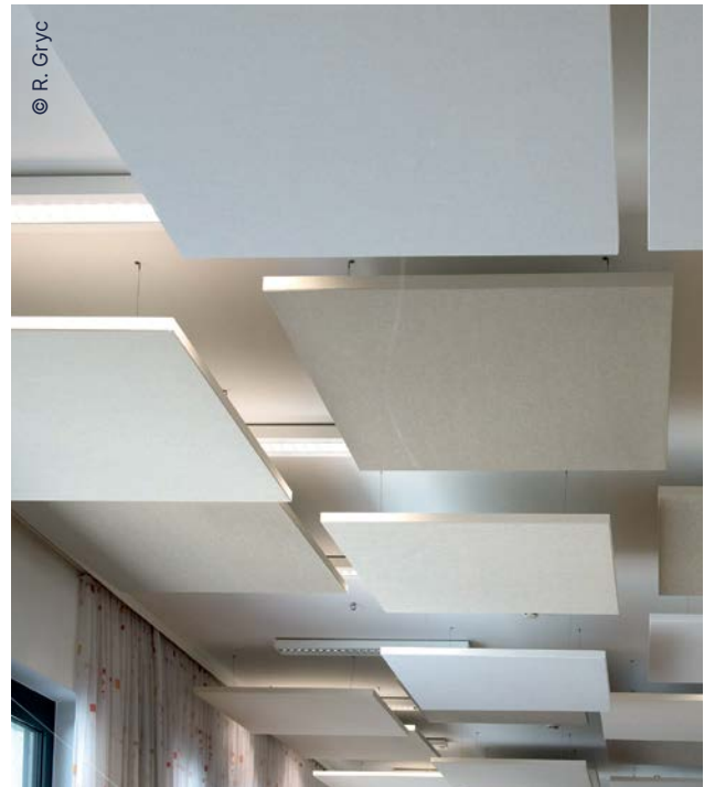
Abb. 9: Deckensegel können auch an Bauteilen mit Betonkernkühlung verwendet werden, da diese Flächen nicht komplett verdeckt werden.
