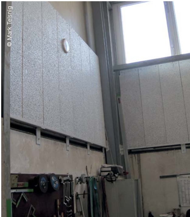
Abb. 10: Auch an den Wänden sollte man schallabsorbierendes Material vorsehen.
