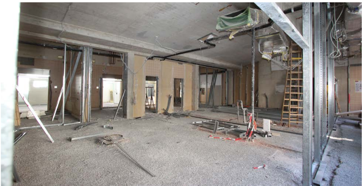
Operationssäle vor Umbau
