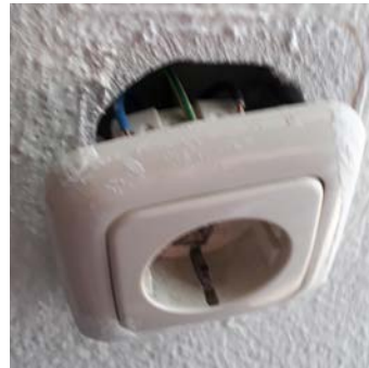
Abb. 10: Beschädigte Steckdose teilweise aus der Wand gerissen
